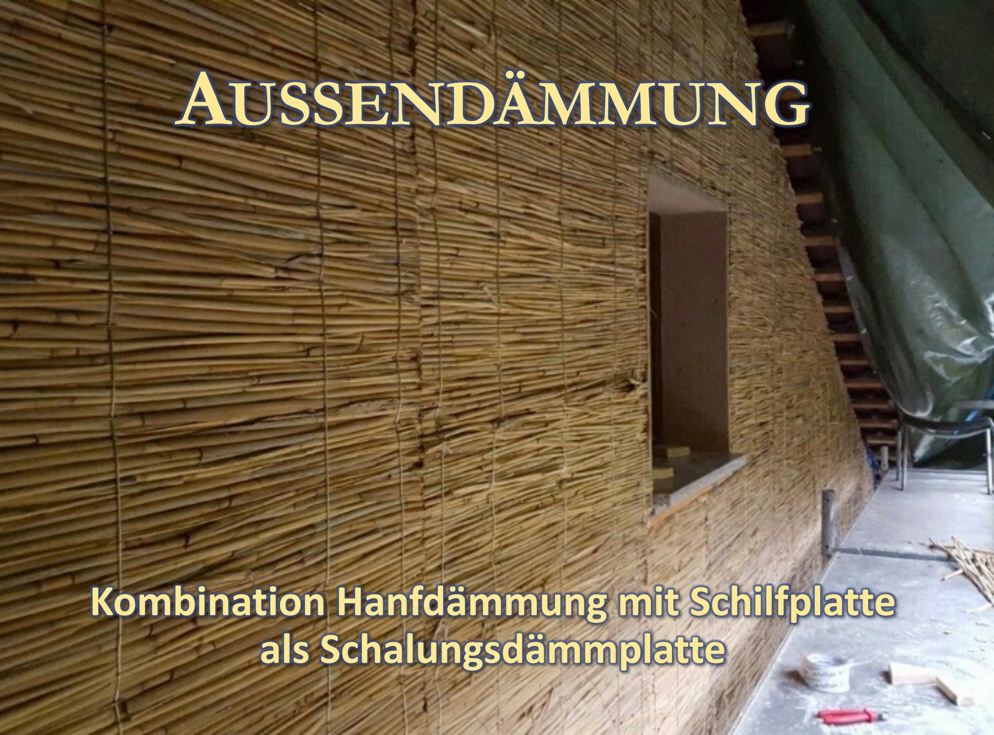
**Kombination Hanfdämmung mit Schilfplatte
