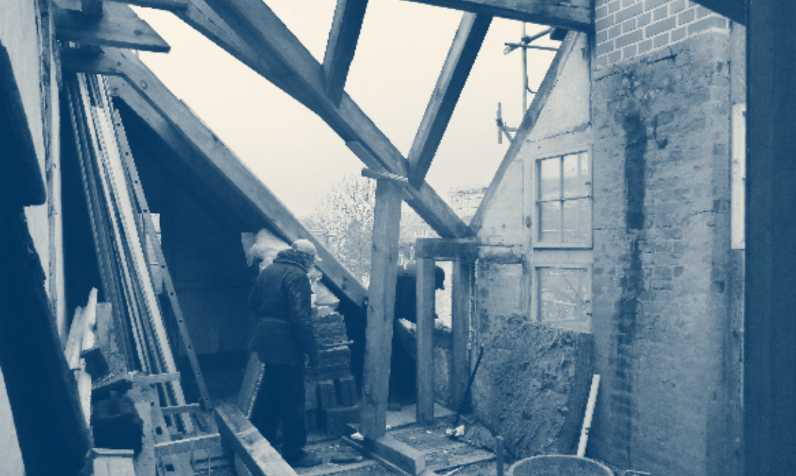
Sanierungsarbeiten am Dach der Villa Ellernholzstraße 1/3 in 2011
